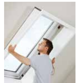
5. Alignez le passage de lumière assemblé avec les pinces de montage et cliquez pour installer
