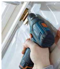
3. Installez les pinces de montage sur la rainure de plaque de plâtre du puits de lumière
