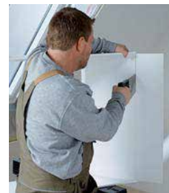
4. Mesurez et coupez les panneaux à la bonne profondeur et joindre à la moulure
